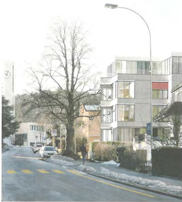
Sicht begriffen von der Utikonstrasse
